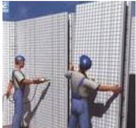
La remarquable légèreté du panneau G.P. confère une certaine facilité et rapidité de transport et de manutention. Les panneaux G.P. peuvent être positionnés manuellement et sont reliés entre eux à l'aide d'un pistolet pneumatique ou avec un simple fil de fer de construction.
