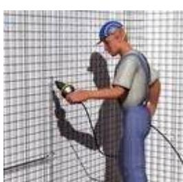
Les marquages peuvent être créés grâce à la fonte du polystyrène derrière la grille métallique au moyen d'un pistolet à air chaud ou d'une quelconque source de chaleur.
