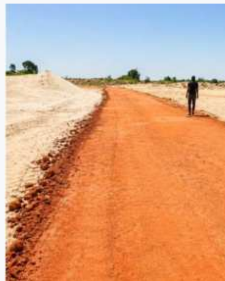
PRÉPARATION ET MISE EN FORME DE LA PLATEFORME
